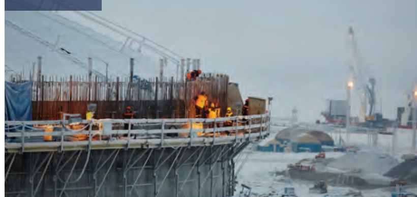
The LNG arctic gas tank under construction
